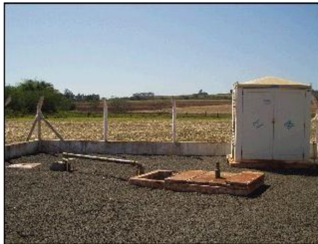
Figura 19. –Poço tubular profundo 01/ Água Boa.
