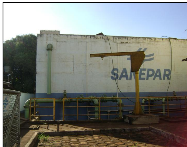
Figura 17. Reservatório Apoiado – 03 (1000 m 3 ) / Paçandu.
