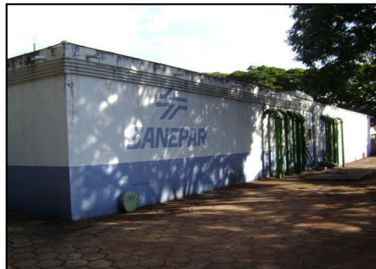
Figura 16. Reservatório Apoiado –02 (750 m 3 ) / Paçandu.
