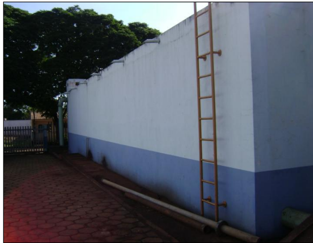
Figura 15. Reservatório Apoiado – 01 (500 m 3 ) / Paçandu.
