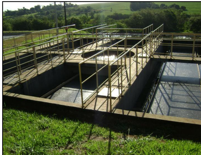
Figura 24. Reator Anaeróbio de Lodo Fluidizado – (Capacidade:20 L/s) / Paiçandu.
